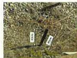
突き出したアングル
